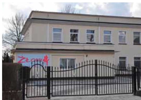
Budynek żłobka przy ul. Ks. Duszy 1 w Krapkowicach źródło: Urząd Gminy Krapkowice
