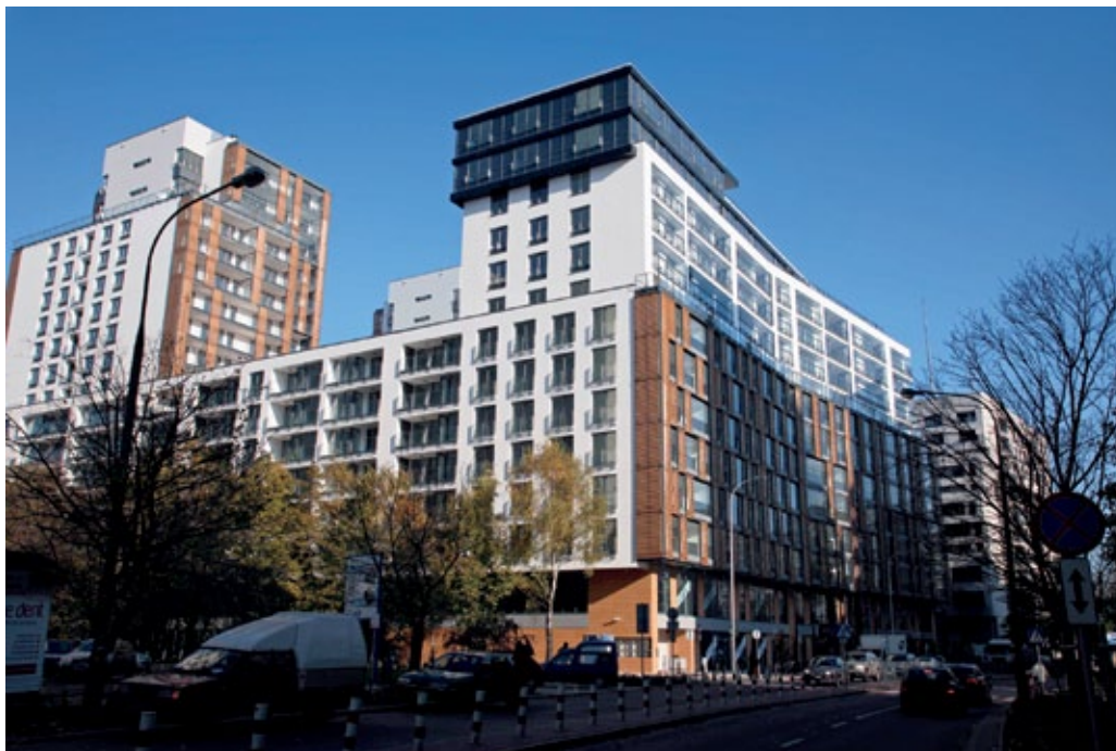
Inteligentny budynek – instalacje wykonane przez firmę Coral. / Intelligent building – installation was executed by Coral Company.
